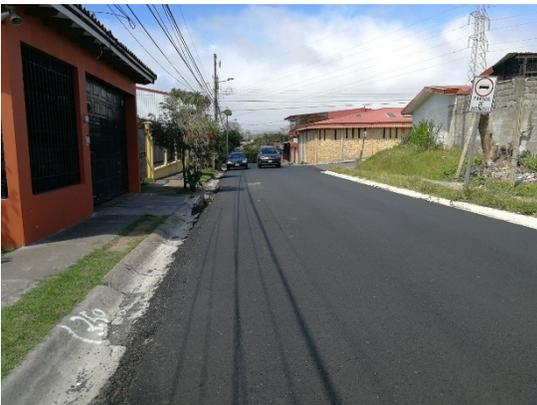
*Imagen 7 Colocación de carpeta asfáltica en Jardines de Moravia*
