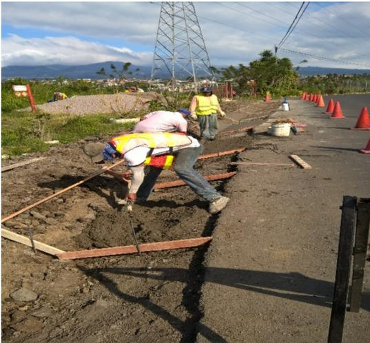
*Imagen 6 Construcción de canalización en calle La Isla*
