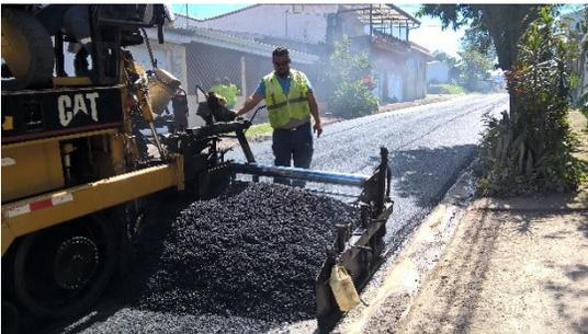
Imagen 2 Colocación de capa de protección de base
