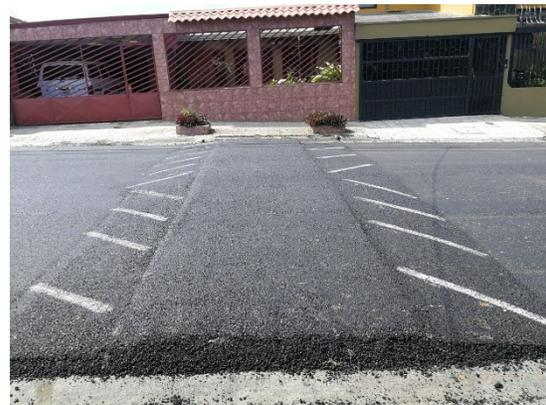
*Imagen 10 Construcción de paso a desnivel en la cercanías del centro diurno*
